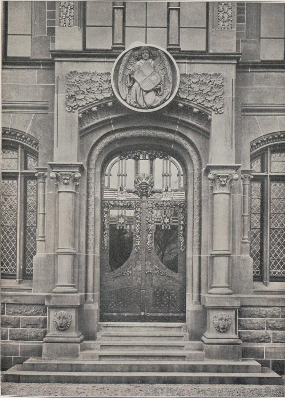
Abb. 201. Gymnasium in Freiburg. Ansicht des Eingangsportales.
