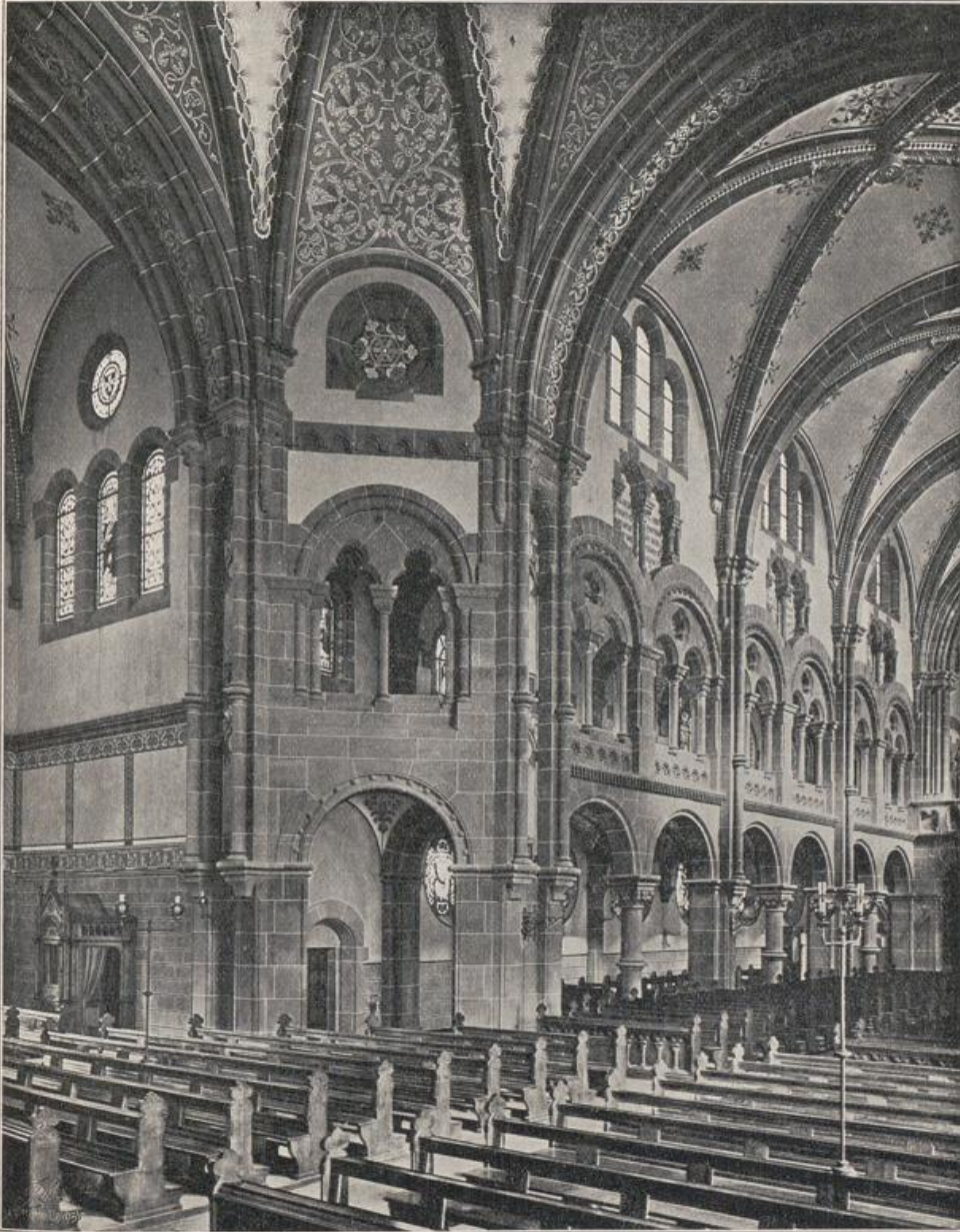
Abb. 244. Inneres der Wiehre-Kirche in Freiburg i. B. Architekt: Dr. JOSEF DURM.
