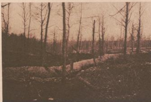
Graben an der West-Tranchée.
