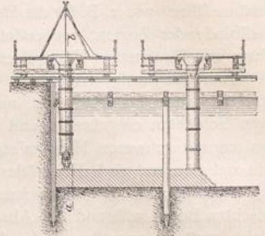
nächsten werden dann die einzelnen Streifen senkrecht zur Richtung der zuerst hergestellten ausgeführt und so fortgefahren, bis die Betonschicht die erforderliche Stärke besitzt. Die unten an dem Trichter befindlichen Walzen dienen zur Einebnung der frisch geschütteten Betonstreifen.
