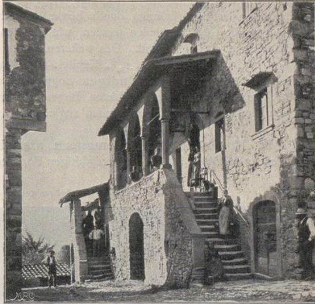
Abb. 193 u. 194. Den Mauern vorgesetzte Bogen.
