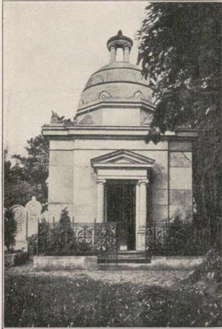
Abb. 345 <sup>27)</sup> angeführt, die ein, von dem Verfasser dieses Kapitels errichtetes Mausoleum darstellt. Zur Erzielung eines möglichst festen Verbandes der einzelnen Wölbeschichten
