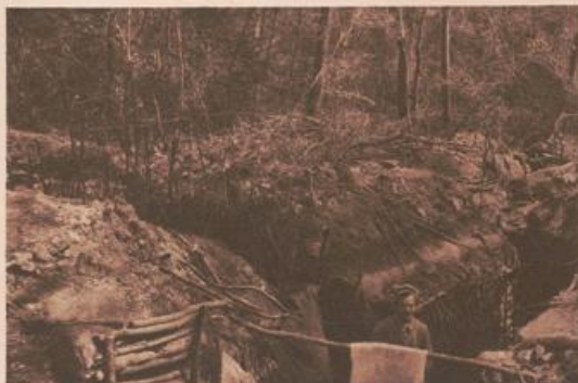
Deutscher Graben an der West-Tranchée.
