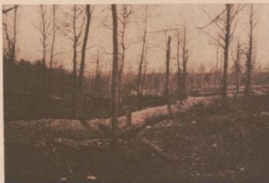
Graben an der West-Tranchée.
