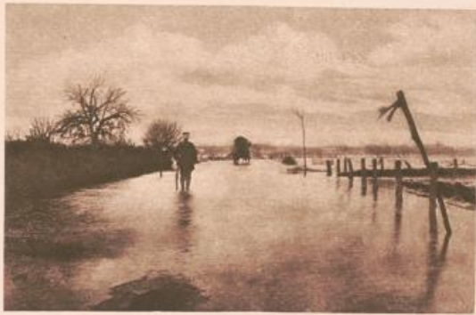
Hochwasser auf der Straße Parfondrupt-St. Jean.
