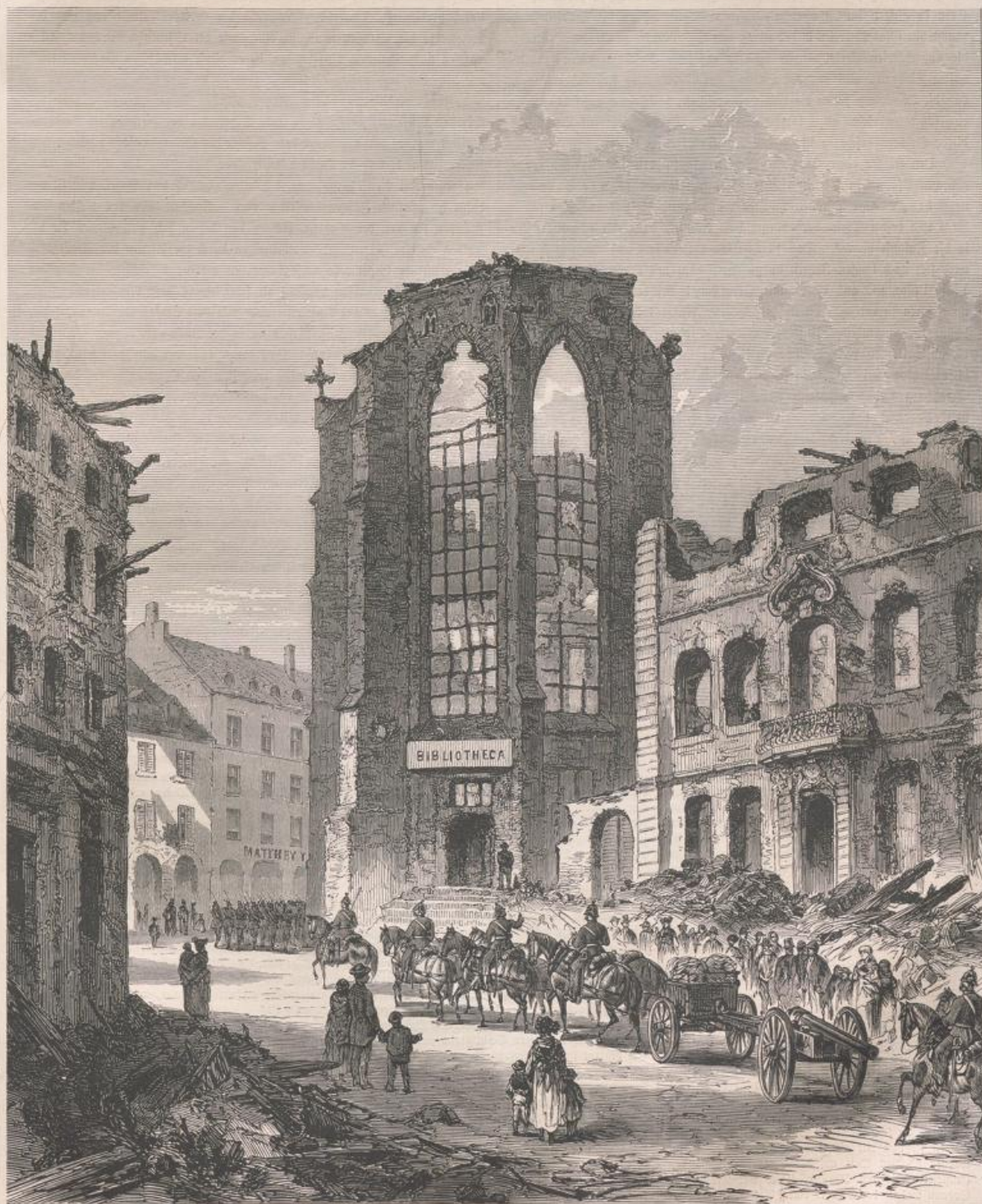
Das zerstörte Bibliotheksgebäude in Strassburg.
