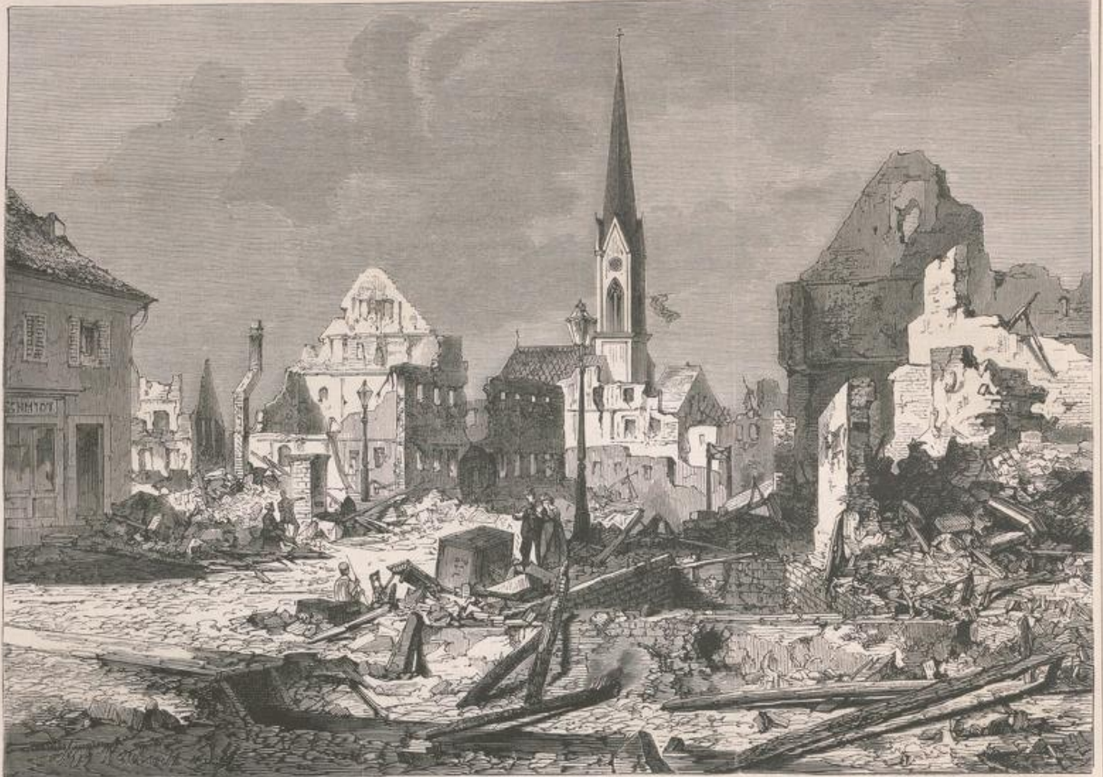
Die Verwüstungen in der Hauptstrasse zu Aehl durch die Beschießung.
