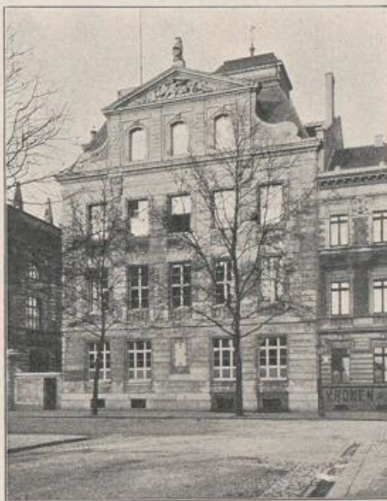
Abb. 268. Erweiterung der Oberrealschule.
