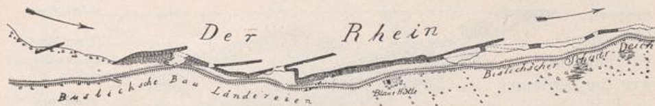
Abb. 705. Uferdeckung vor dem Bislicher Schardeich, Zustand im Jahre 1779 (nach Eversmann). 1 cm = 30 rh. Ruthen.
