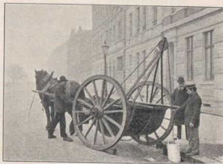
Reinigung der Strassensinkkasten.
