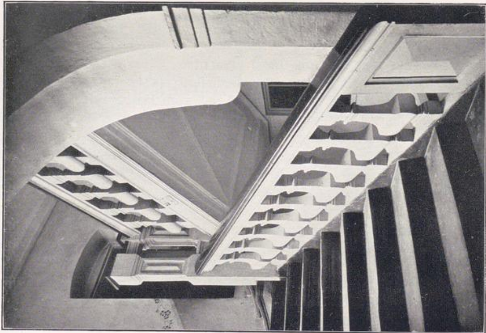
Koblenz. Treppe im Drei-Königen-Haus, Kornfortstraße 15 (Anfang 18. Jahrh.) (vgl. Bild S. 240).
