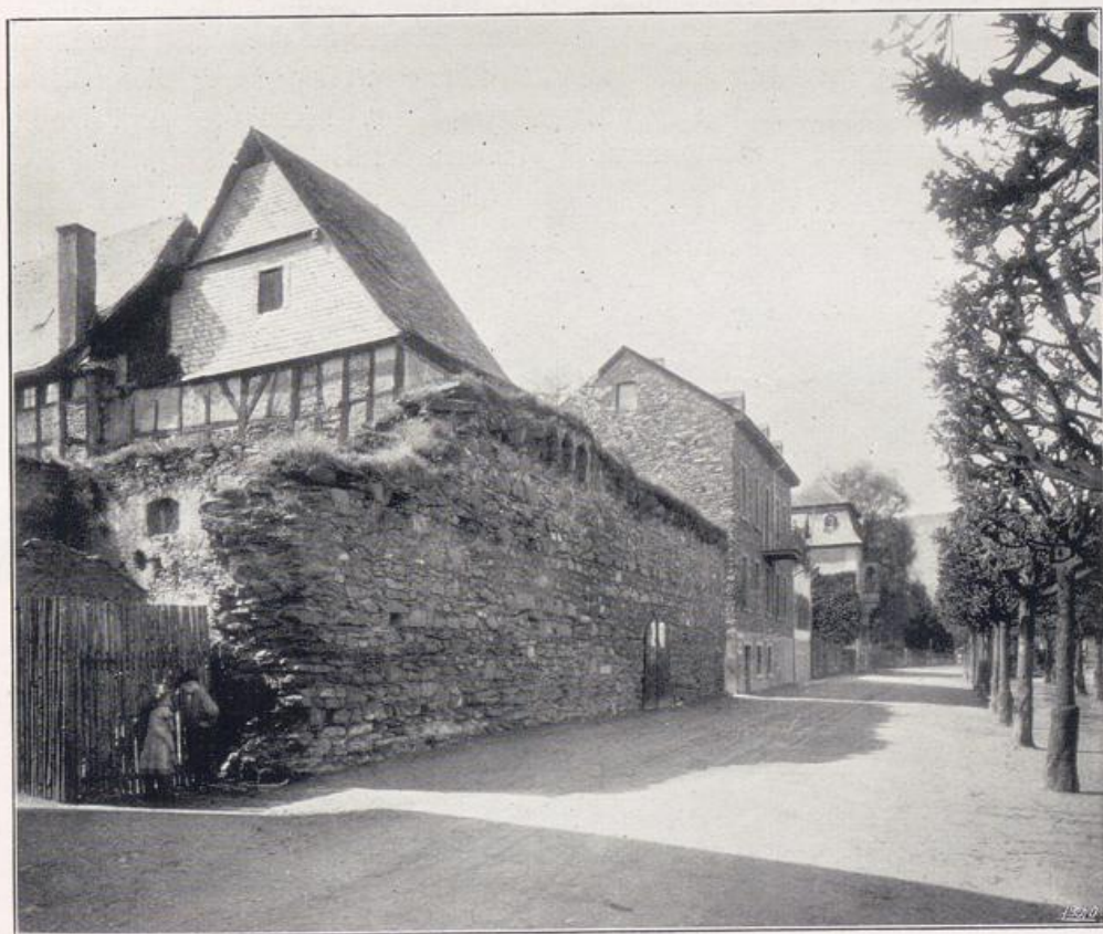
Boppard. Mittelalterliche Stadtmauer an der Rheinseite.
