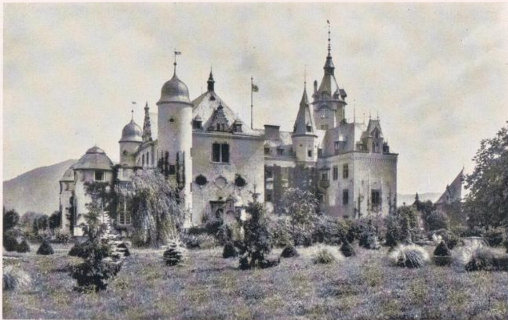
Burg Namëdy. Nach dem Ausbau. — Vgl. Bild S. 296.
