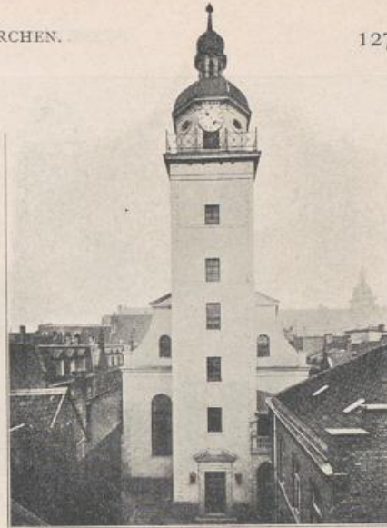
Abb. 146. Turm der Kirche an der Bolkerstrasse.
