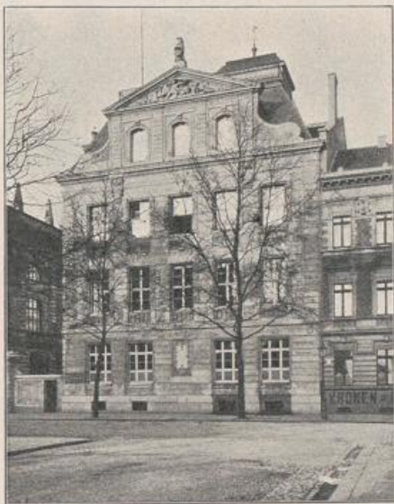
Abb. 268. Erweiterung der Oberrealschule.
