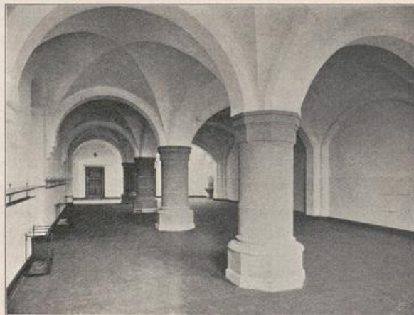
Abb. 302. Innenansicht des Flurs der Schule in Hamm.
