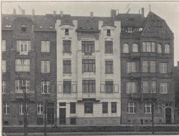
Abb. 695. Etagenhäuser der Prinz-Georgstrasse 81/83.
