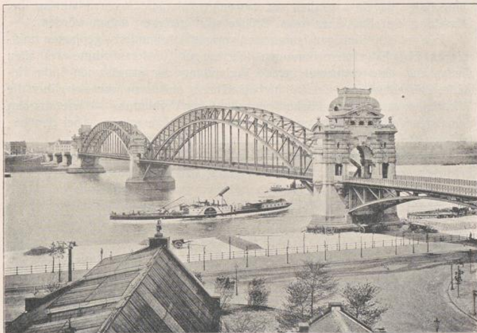
Blick auf die Rheinbrücke von der Kunstakademie aus.
