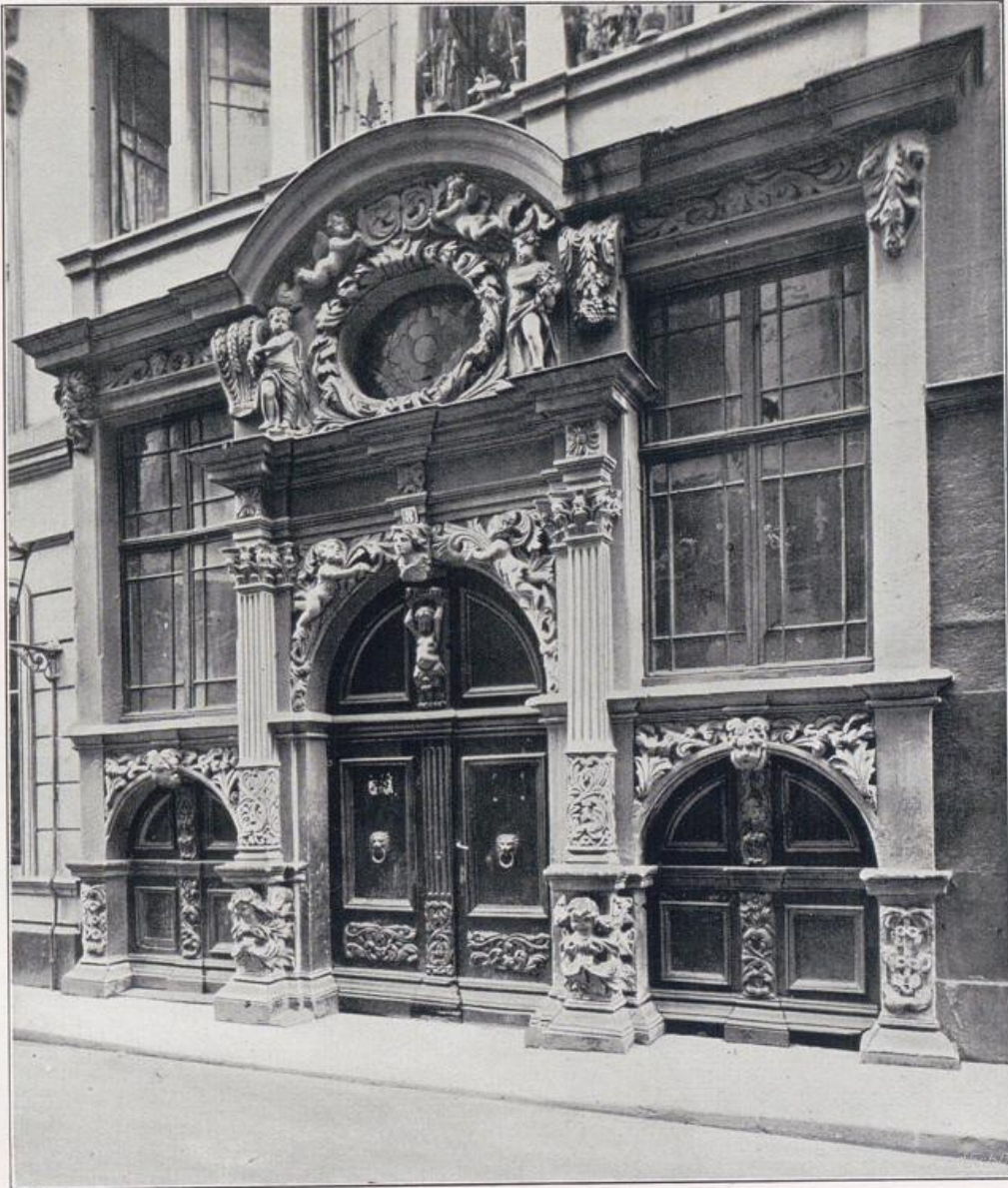
Köln — Haus zum Maulbeerbaum. Ehemaliger Zustand an der Sandbahn 8 — vgl. Bild S. 185.
