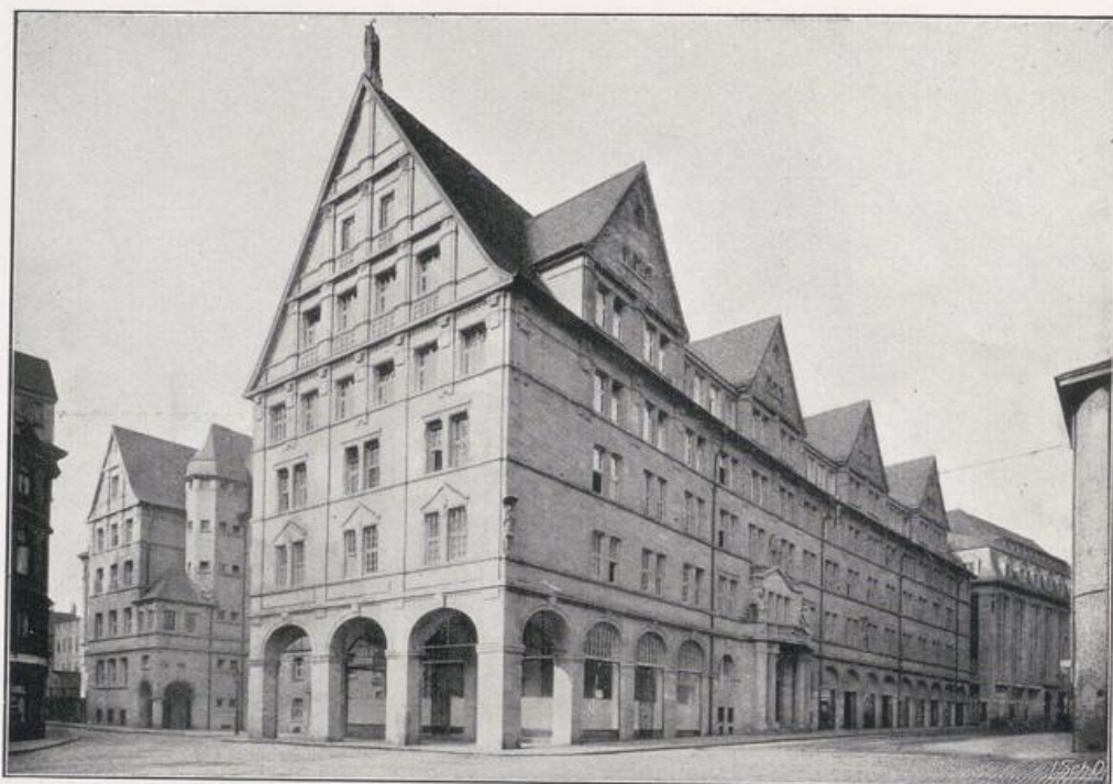
Köln — Stadthaus. Architekt Friedrich Bolte.
