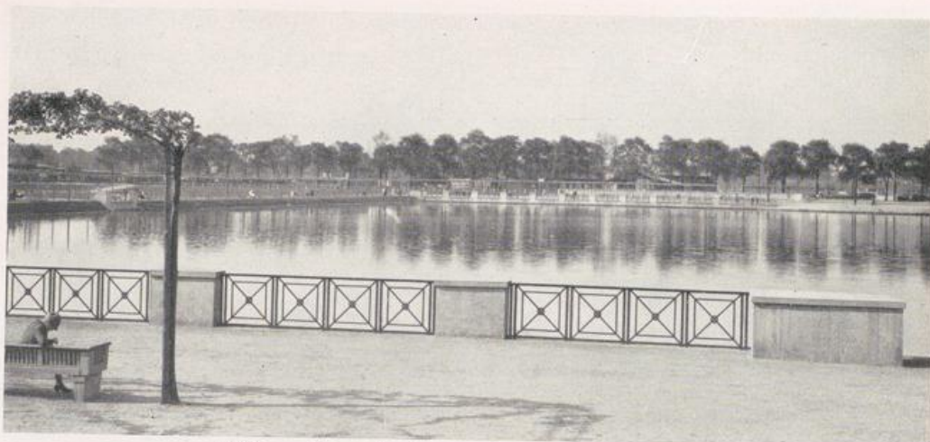
Köln — Wasserbecken an der Aachener Straße. Fortsetzung S. 245. — Vgl. Bild S. 17.
