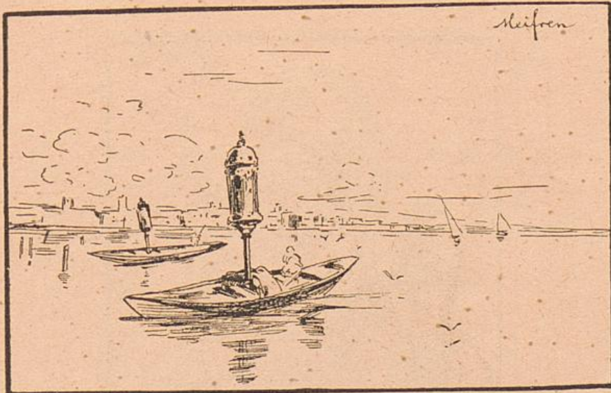
836. Lampentransport in der Lagune.
