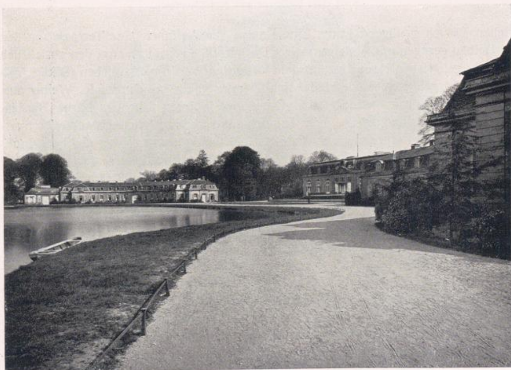
Schloß Benrath. Blick auf einen der Seitenbauten. Gesamtansicht S. 67.
