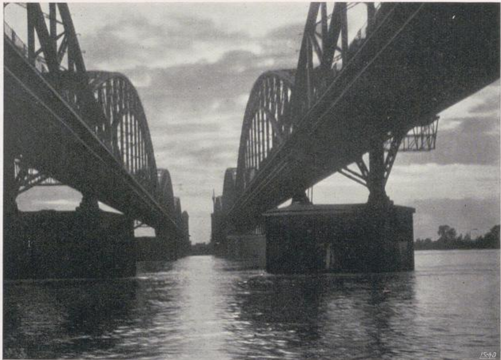
Die beiden Eisenbahnbrücken Neuß—Düsseldorf.
