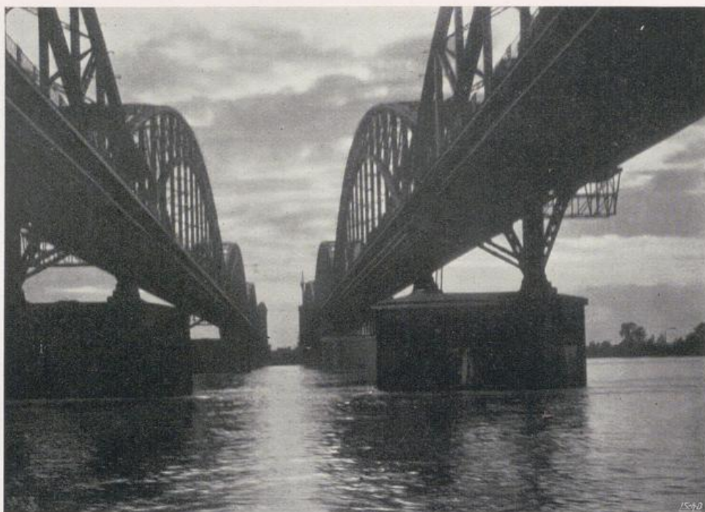
Die beiden Eisenbahnbrücken Neuß—Düsseldorf.
