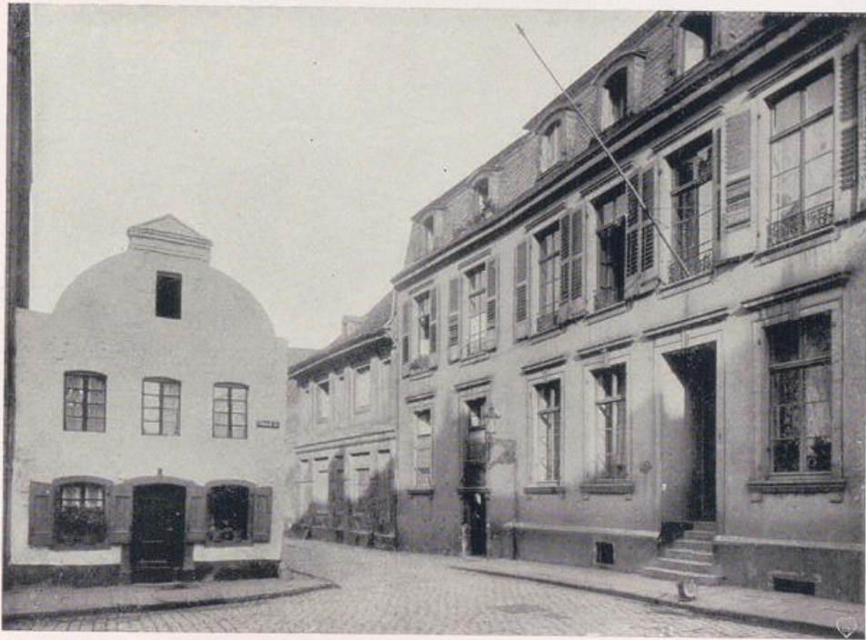
Düsseldorf. Das Nesselrodesche Absteigequartier an der Schulstraße. Erbaut um 1760. Das Giebelhaus links abgebrochen.
