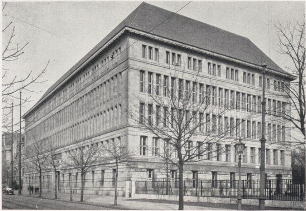
Düsseldorf. — Mannesmann-Verwaltungsgebäude. Architekt Peter Behrens.
