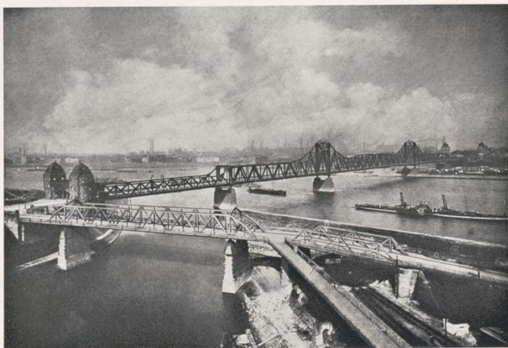
— Die Homberger Rheinbrücke. Im Hintergrunde die Hütte Phoenix. — Vgl. Bild S. 134.
