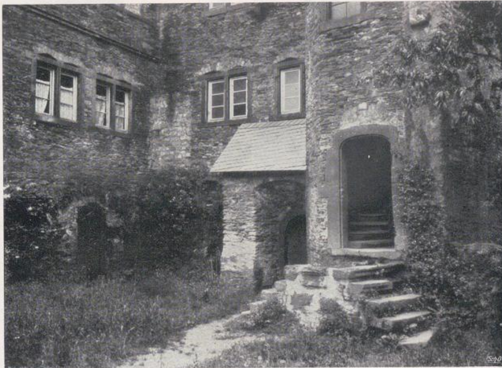
Oberhammerstein. Ehemaliges Burghaus. Anfang 16. Jahrh.
