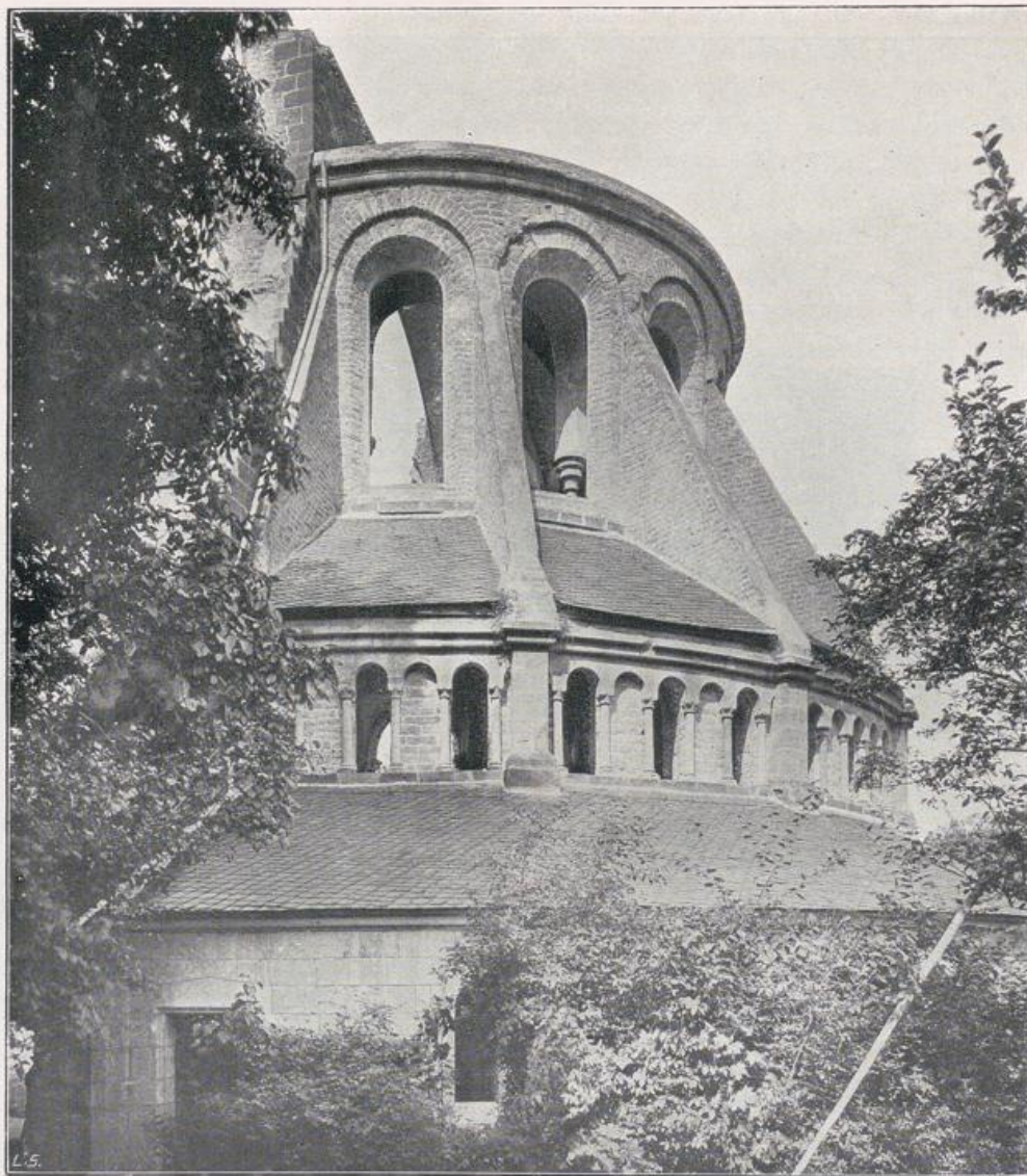
Heisterbach. Ruine der Abteikirche. Außenansicht des Chores.
