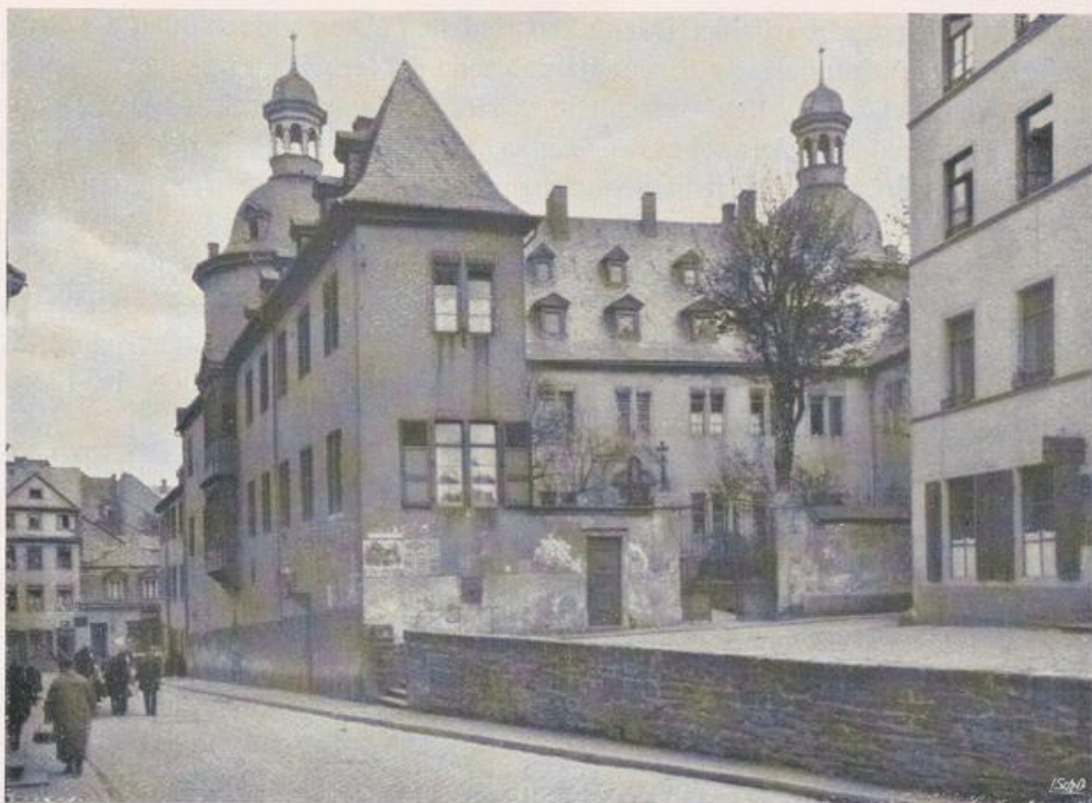
Koblenz. Pfarrhaus Unserer Lieben Frauen. Früher Hofgericht. Ursprünglich Pfalz der fränkischen Könige, dann erzbischöfliche Residenz. Türme noch römischen Ursprungs. Umbau nach 1688: Seitenerker, Turmhauben und Dach.
