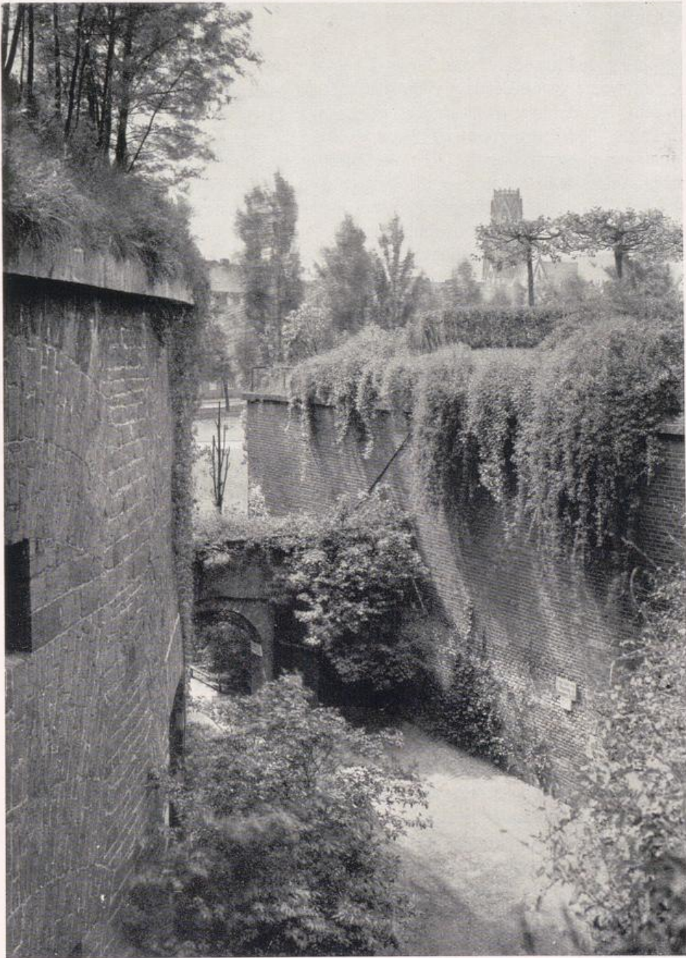
Köln — Ehemaliges Fort am Neußer Wall. Grabenstück nach der Umgestaltung in Grünanlagen. — Vgl. Bilder S. 240—242.
