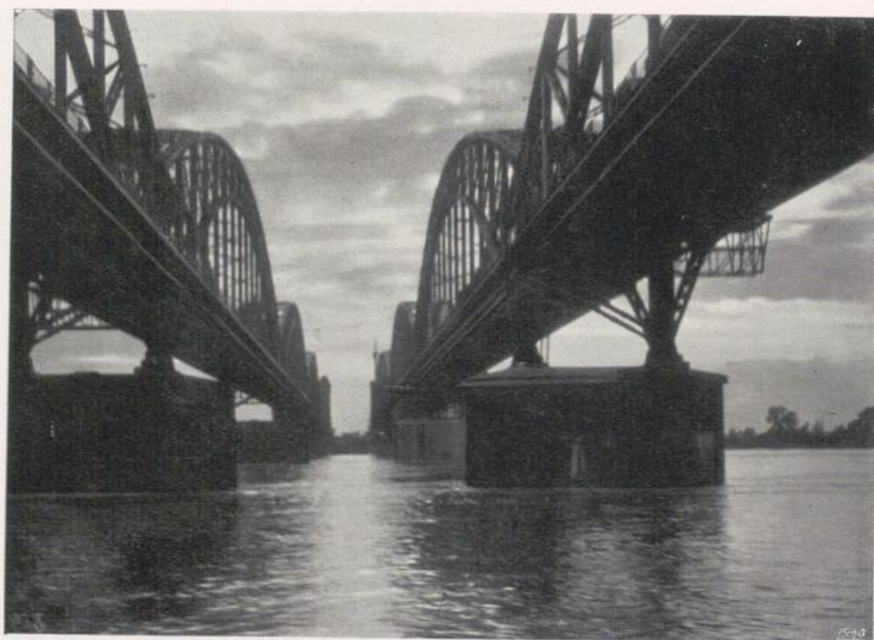
Die beiden Eisenbahnbrücken Neuß—Düsseldorf.
