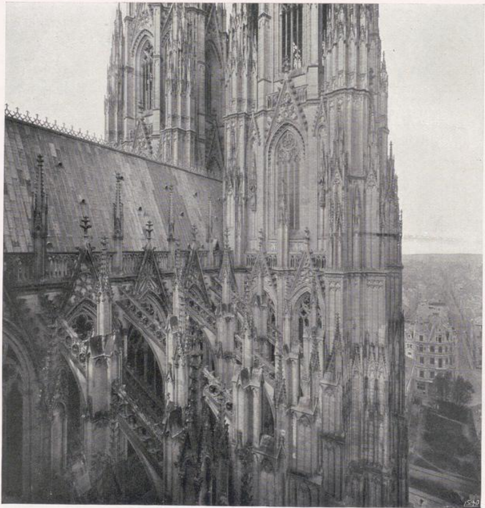
Der Dom zu Köln. Blick in die Strebepfeiler des nördlichen Seitenschiffes.
