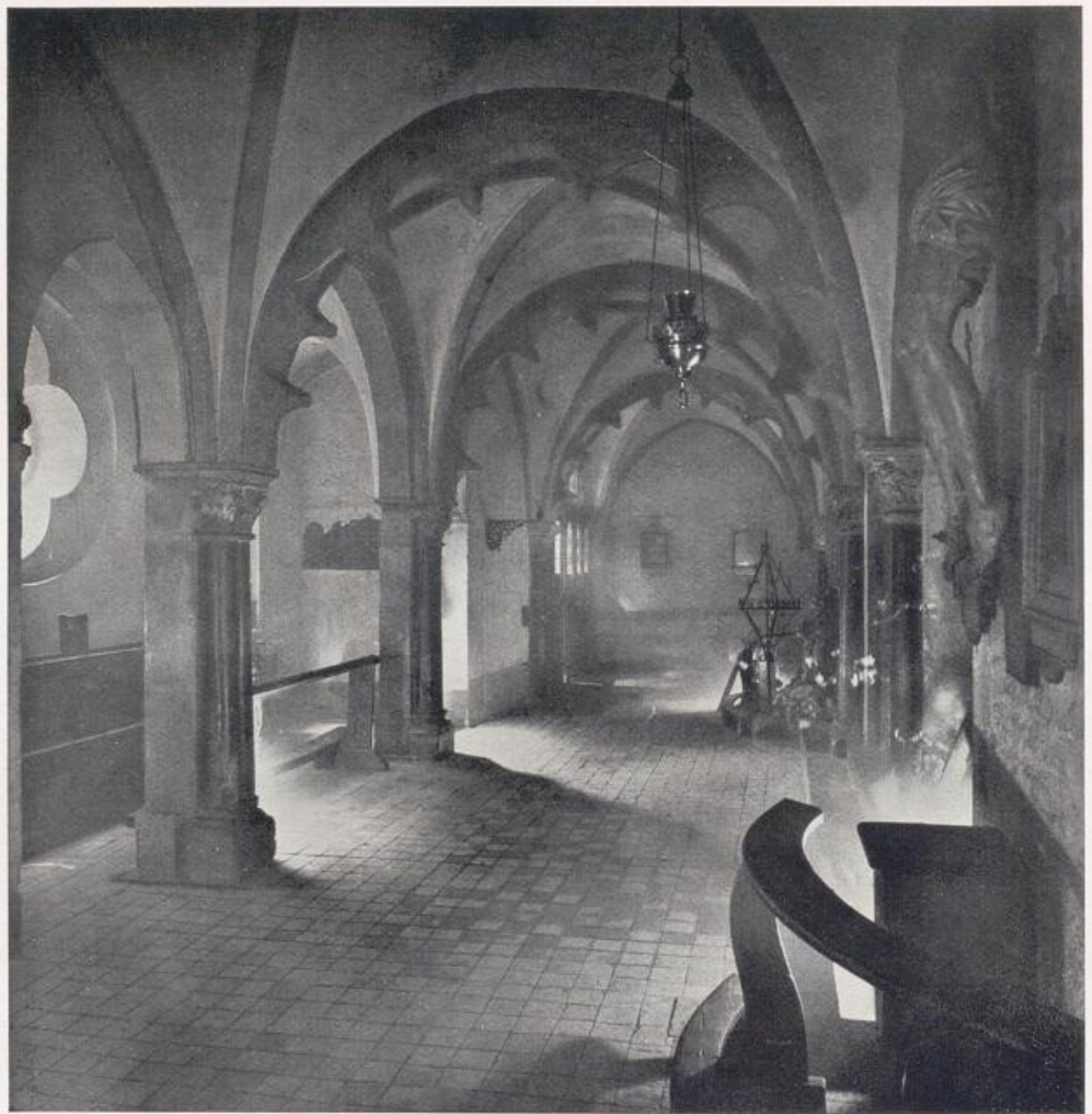
Köln — St. Andreas. Blick in die Vorhalle um 1200.
