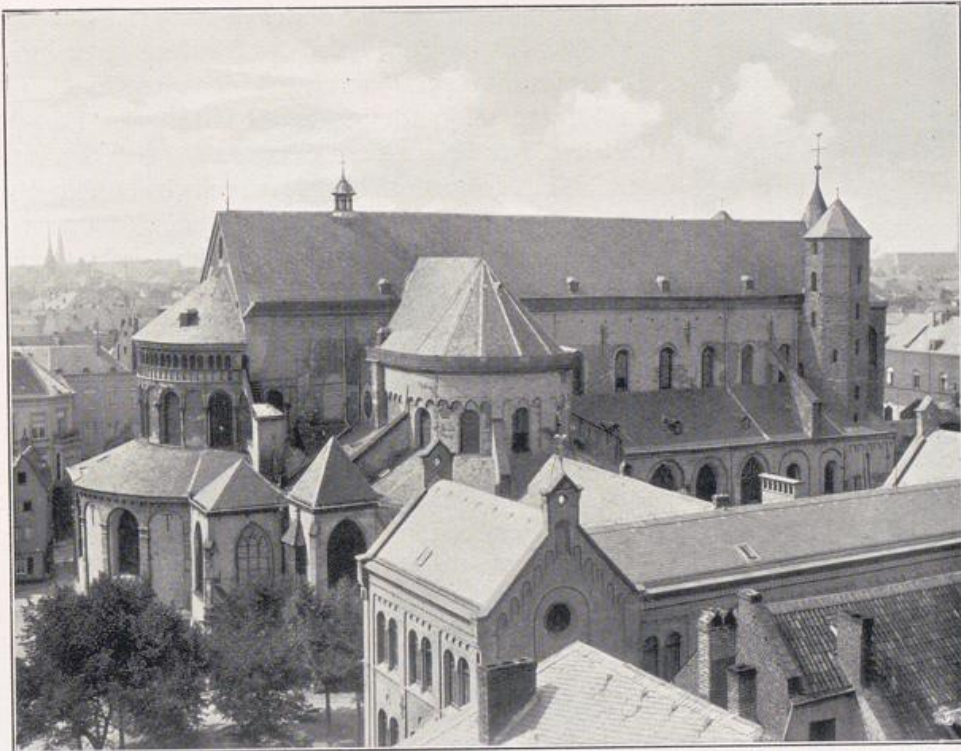
Köln — St. Maria im Kapitol. Ansicht von Nordosten vgl. Bild S. 167.
