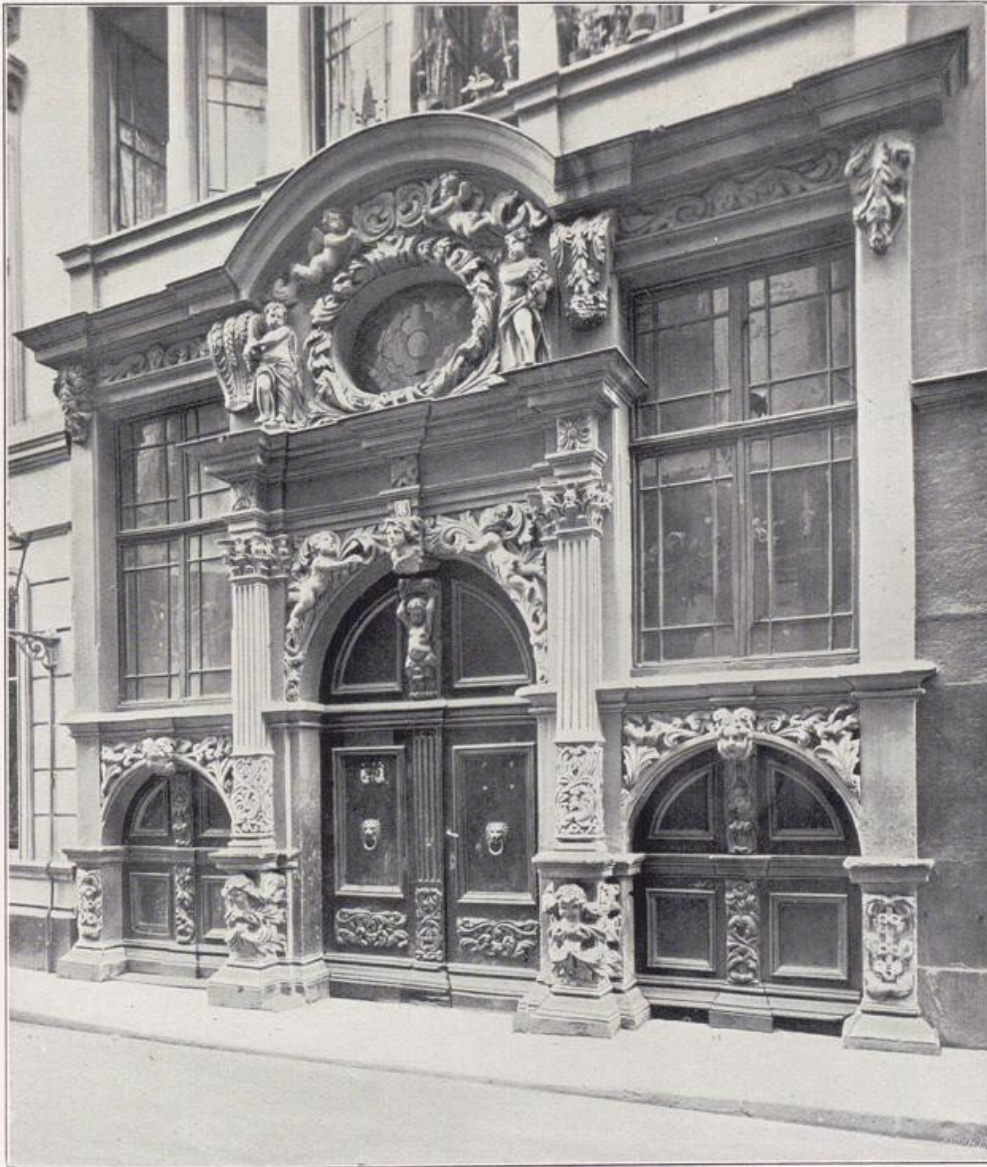
Köln — Haus zum Maulbeerbaum. Ehemaliger Zustand an der Sandbahn 8. — Vgl. Bild S. 189.
