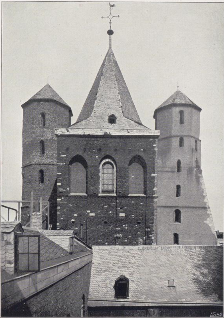
Köln — St. Maria im Kapitol. Ansicht des Westbaus, heutiger Zustand. — Vgl. Bild S. 172.
