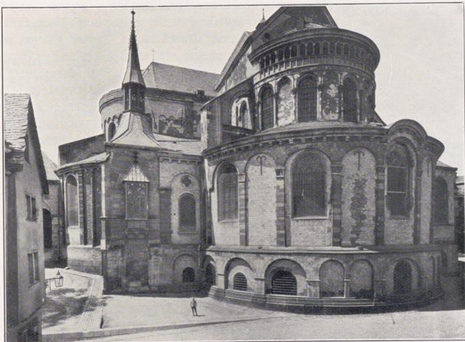
Köln — St. Maria im Kapitol. Ansicht von Südosten.
