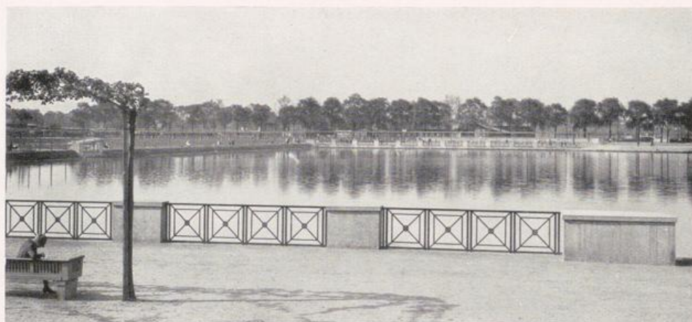
Köln — Wasserbecken an der Aachener Straße. Fortsetzung S. 247. — Vgl. Bild S. 245.
