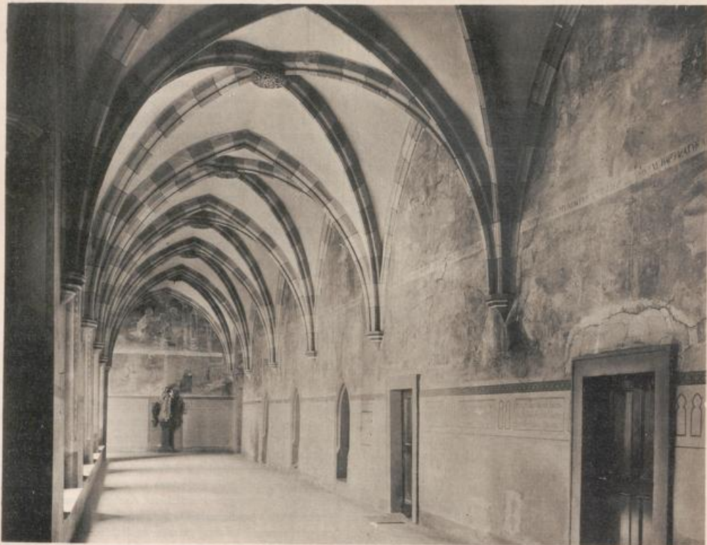
Abb. 4. Südwestecke des Kreuzganges (Westflügel) mit dem Blick nach der Verkündigung Mariä.
