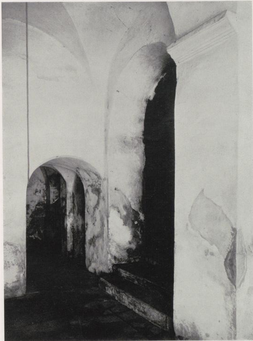
Westwerk, Edgeschoß, Blick in den Eingang zum südlichen Treppenturm
