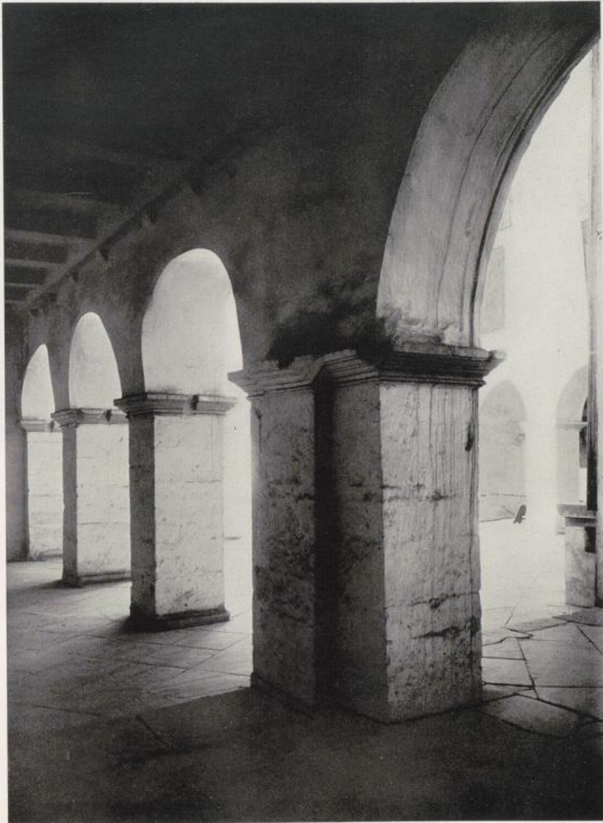
Westwerk, Johanneschor, das südliche Seitenschiff nach Nordwesten
