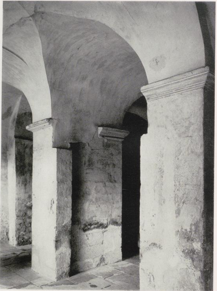
Westwerk, Erdgeschoß, Blick auf die Mittelpfeiler der Westvorhalle nach Nordosten
