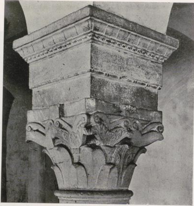
1. Das teilweise durchgearbeitete Kapitell der südwestlichen Säule des Quadrums aus Nordosten
