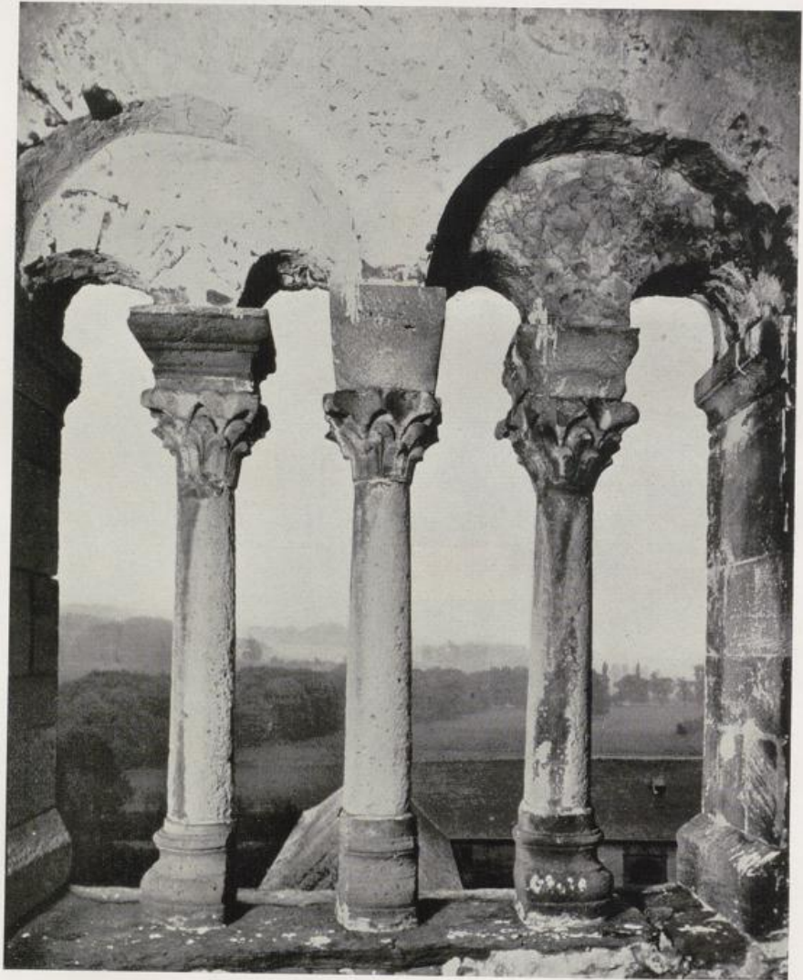
Die südliche Arkade der oberen Glockenstube des Südturms von innen
