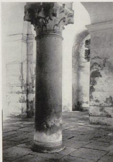
4. Die südöstliche Säule des Quadrums mit angestückeltem Schaftende
