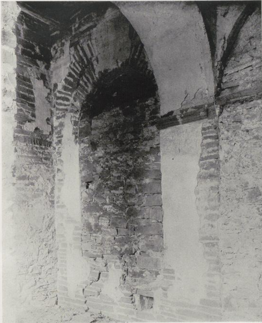
Westempore, Doppelbogenkonstruktion der nördlichen Arkade
