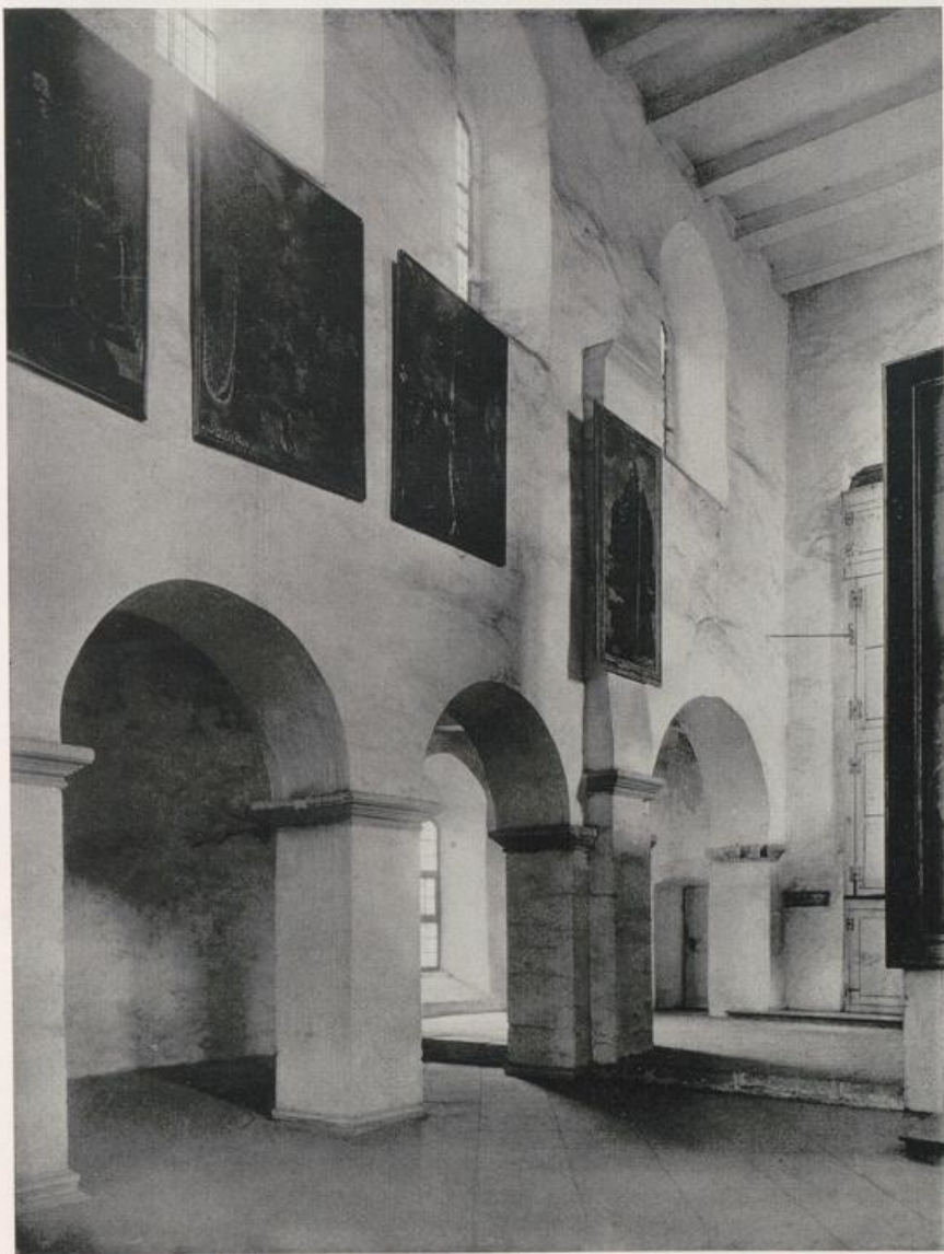
Westwerk, Johanneschor nach Nordosten
