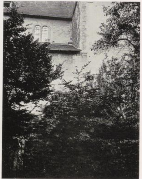
4. Die südliche Hochwand des Johanneschors mit altem Gesimsstück der Emporenarkaden des Ostraums
