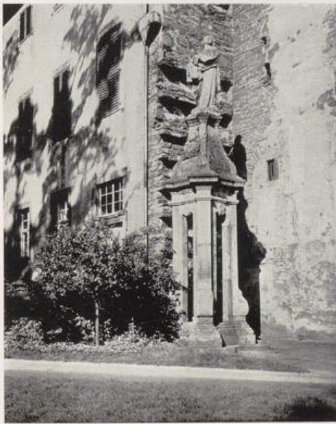
2. Keilsteinbogen vom oberen Atriumeingang auf der Nordseite
