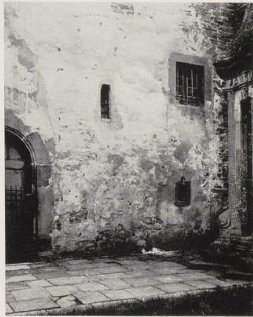
3. Fuge des Bogens des unteren Atriumeingangs auf der Südseite
