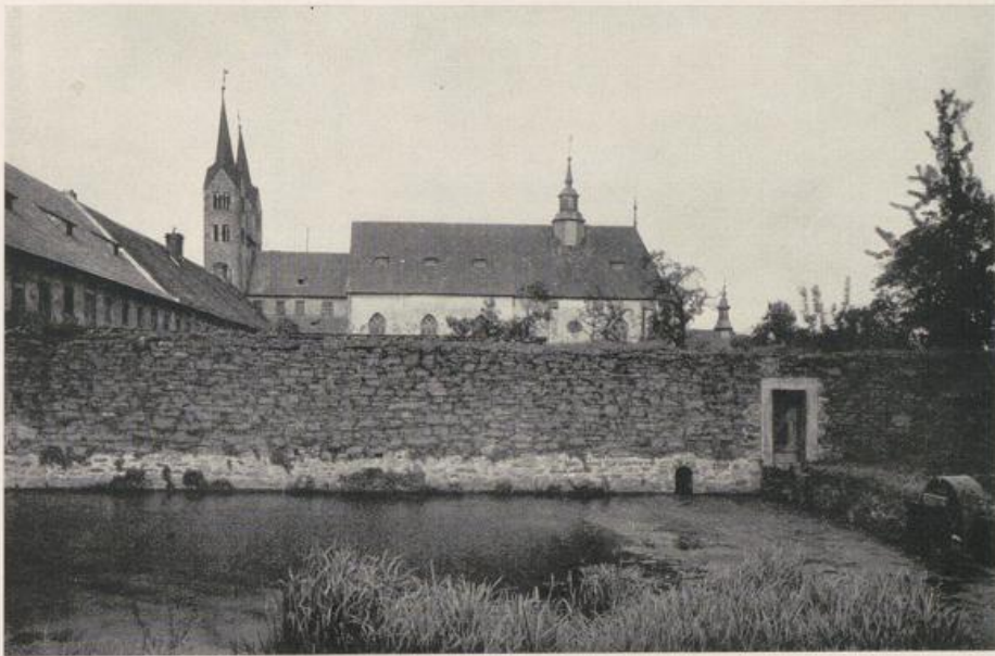
1. Blick auf die Kirche von Süden
