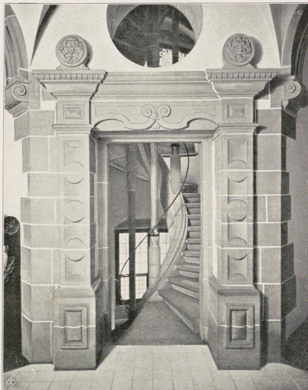
(Abbildung 20) Eingang vom Korridor zur Wendeltreppe.
