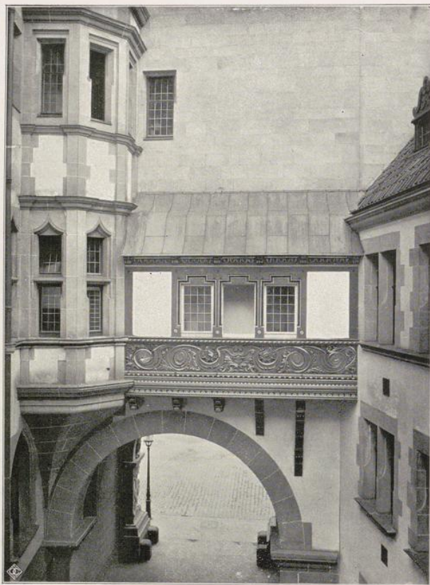
(Abbildung 50) Ausgefragter Balkon im Bogenhof, Turmseite.
