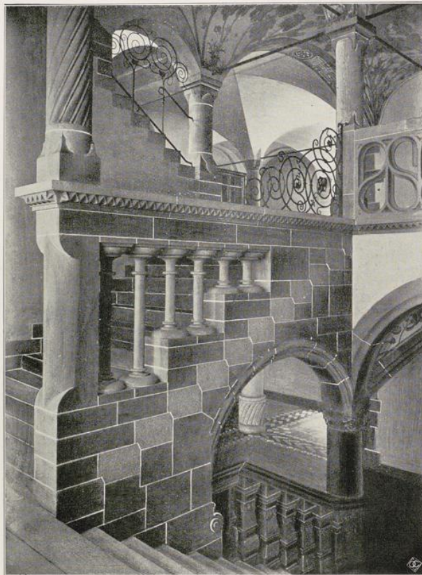
(Abbildung 37) Treppenhaus zum zweiten Obergeschoß.
