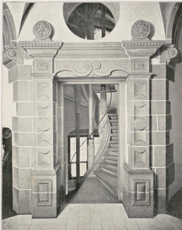
(Abbildung 20) Eingang vom Korridor zur Wendeltreppe.
