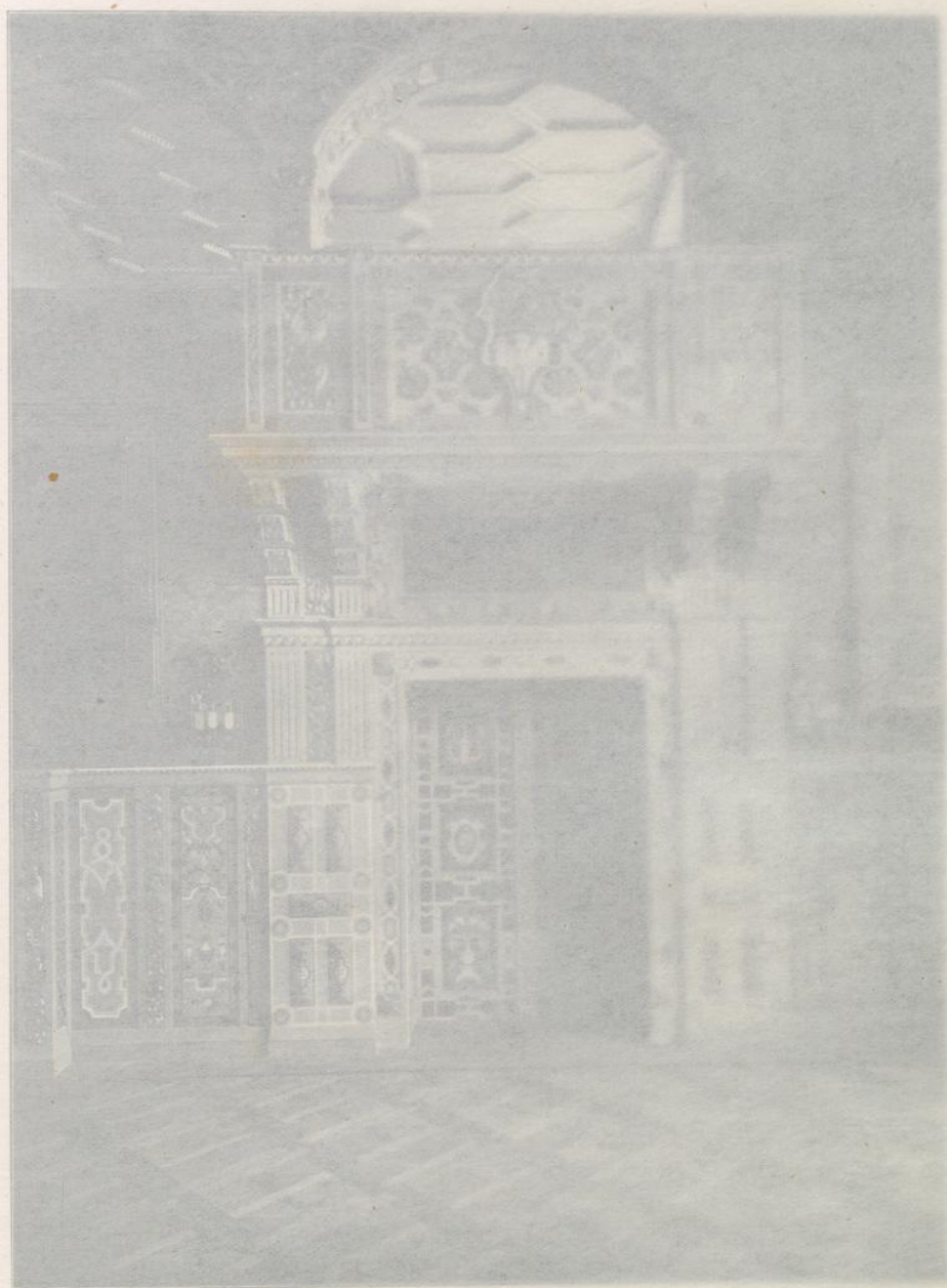
(Abbildung 28) Innenansicht der Querwand nach dem Vorzimmer vom großen Saalgebäude
