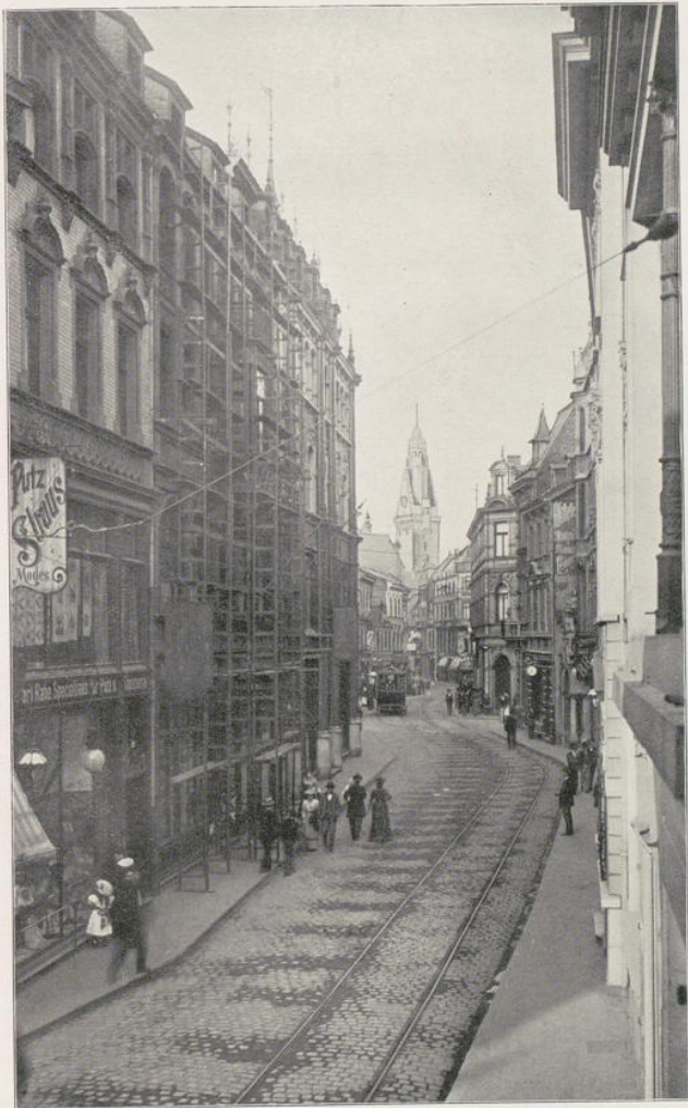
(Abbildung 55) Blick auf den Rathhausturm von der Beekstraße.
