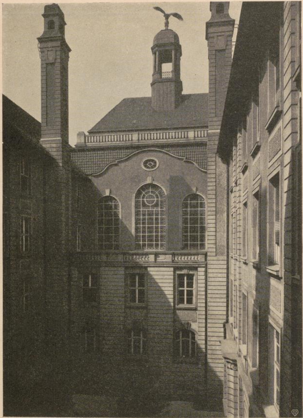
Ansicht des Mittelhofes.
