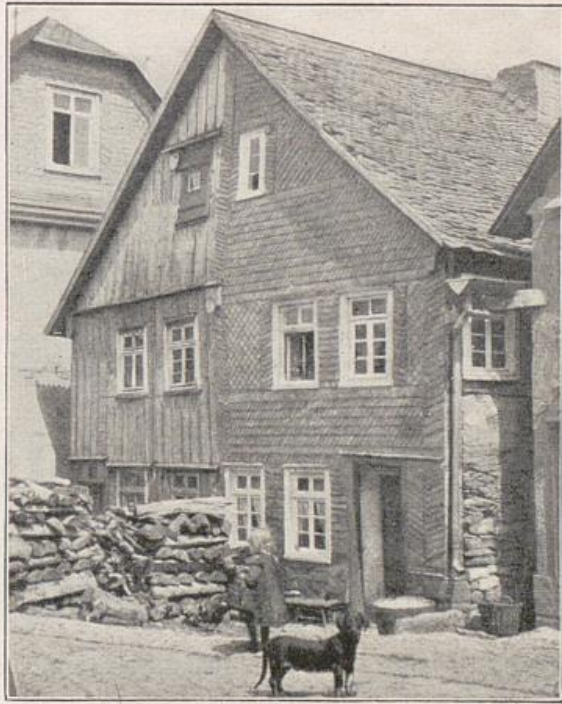
17. Zweifamilienhaus, eine Hälfte mit Brettern, die andere mit Schiefer verkleidet. Battenberg (Hessen-Nassau).
