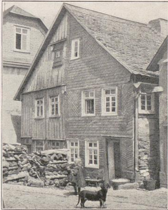
17. Zweifamilienhaus, eine Hälfte mit Brettern, die andere mit Schiefer verkleidet. Battenberg (Hessen-Nassau).
