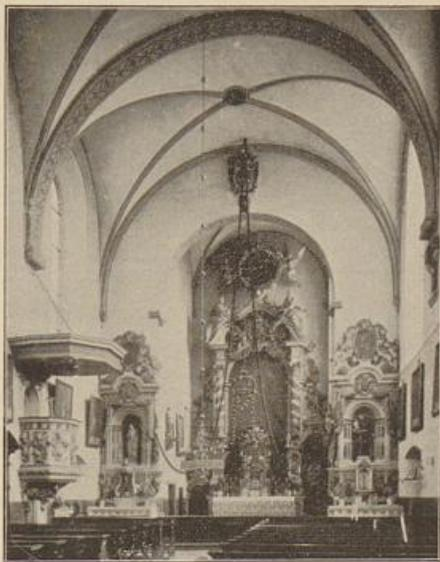
Kreuzgewölbe mit Rippen und Schlüsselsteinen zwischen Quergurten auf Konsolen, im Schiff, Chor und Anbau. Tonnengewölbe im Klosterchor. Glatte Decken in den Sakristeien. Strebepfeiler, nach Westen mit Aufsätzen.
