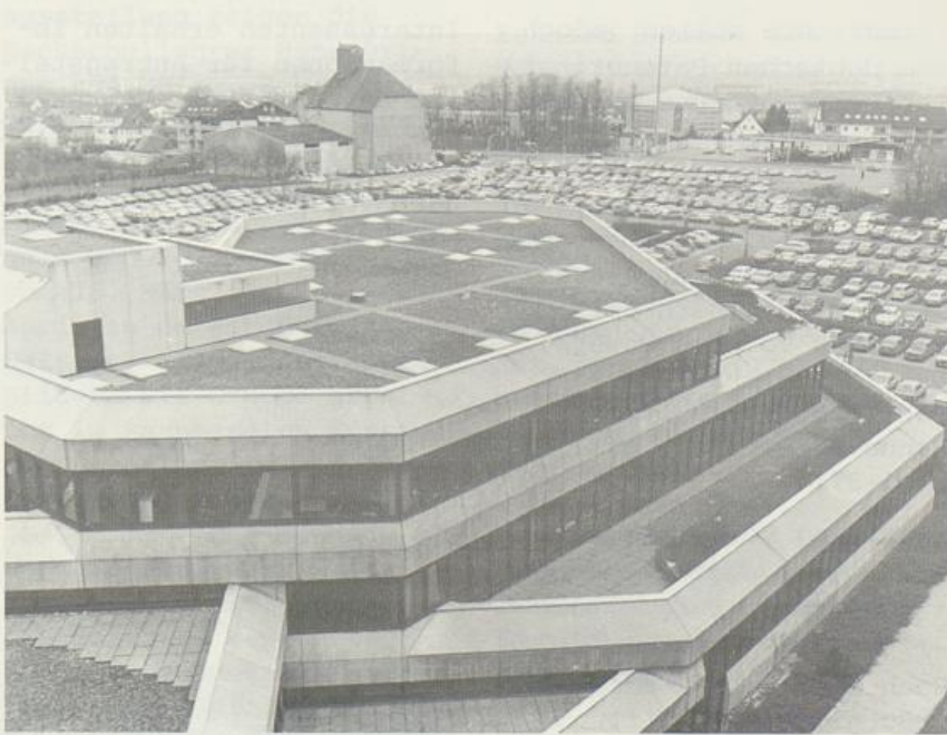
Bücher im Betonrund: Bibliothek von oben
