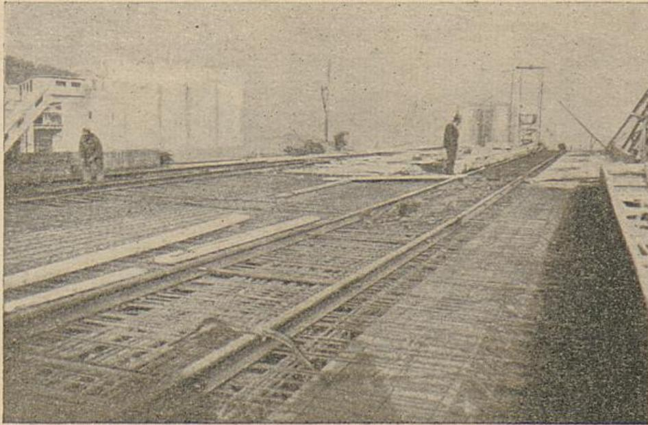
*Gleiseinbau auf einer Brückenarmierung vor Einbau der Schienenstähle.*
