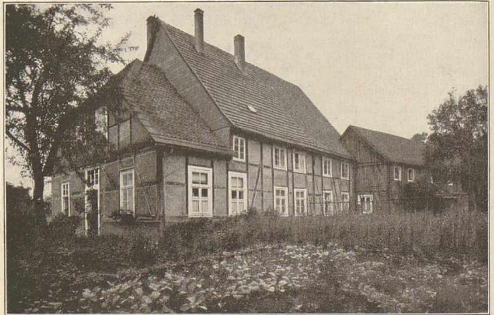
Bild 96. Vormalige Zweite Pastorat, jetziges Pfarrhaus; 1705. Vorbau links 1806; Stallung rechts 1888. Vgl. S. 379 u. Bild 71 S. 380.
